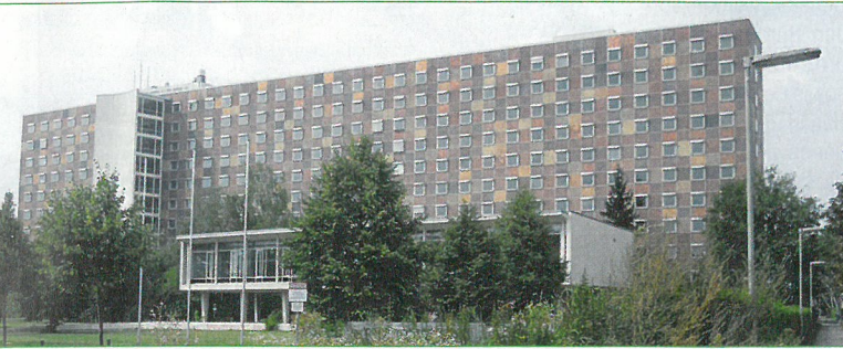
Abriss: Die Tage des alten OFD-Gebäudes sind gezählt Bildquelle: OFD Frankfurt
