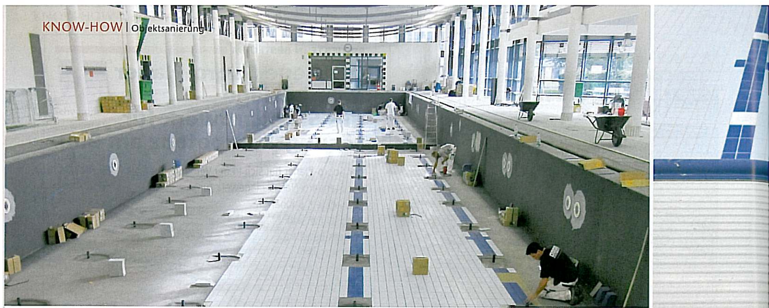
Im „Kombinierten Verfahren“ wurden die Fliesen verlegt.
