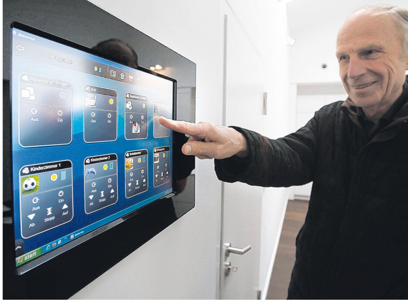
Kommandozone: Ein Gast testet am Dienstag die Funktionen des „Touch Panels“ im Plusenergiehaus in Mühlthal. Mit diesem Stueerelement lassen sich Licht, Heizung und Lüftung im Haus zentral regulieren. Auch vom Smartphone oder Tablet-PC lässt sich das Gerät ansteuern. FOTO: ALEXANDER HEIMANN
