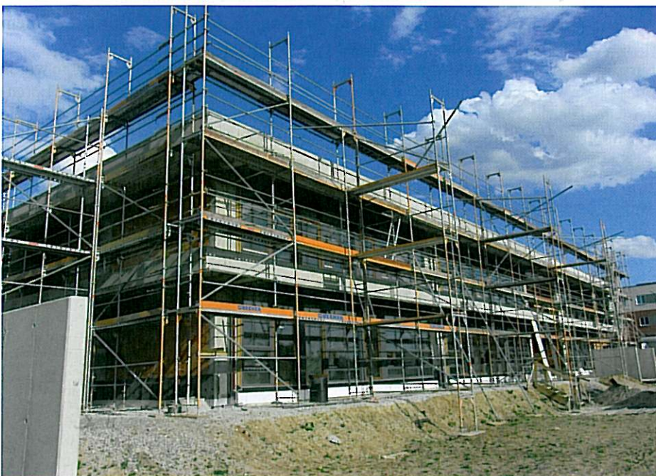
Gut gerüstet! - Kita „Goldpepping“, Frankfurt-Preungesheim
