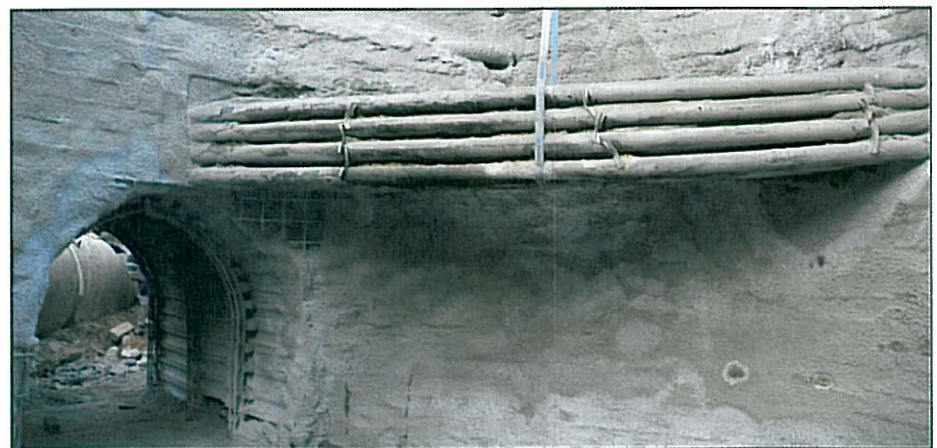
Tunnelanstich aus Spritzbetonschacht
