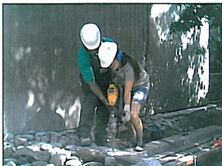
Mauerpicken - Abrissparty am 07.05. 2012
