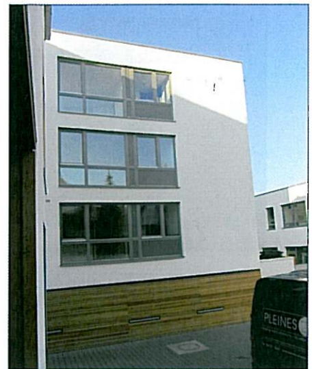
Dreifachverglaste Fenster in Harmonie mit Außenputz und Holzsockel
