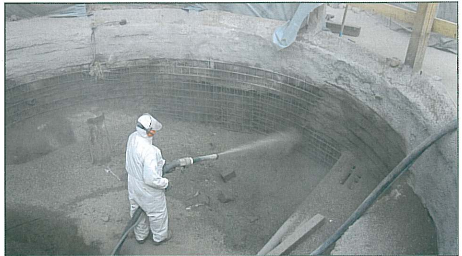
Schachtbauwerk für Ortbetonschacht mit Spritzbetonschalung
